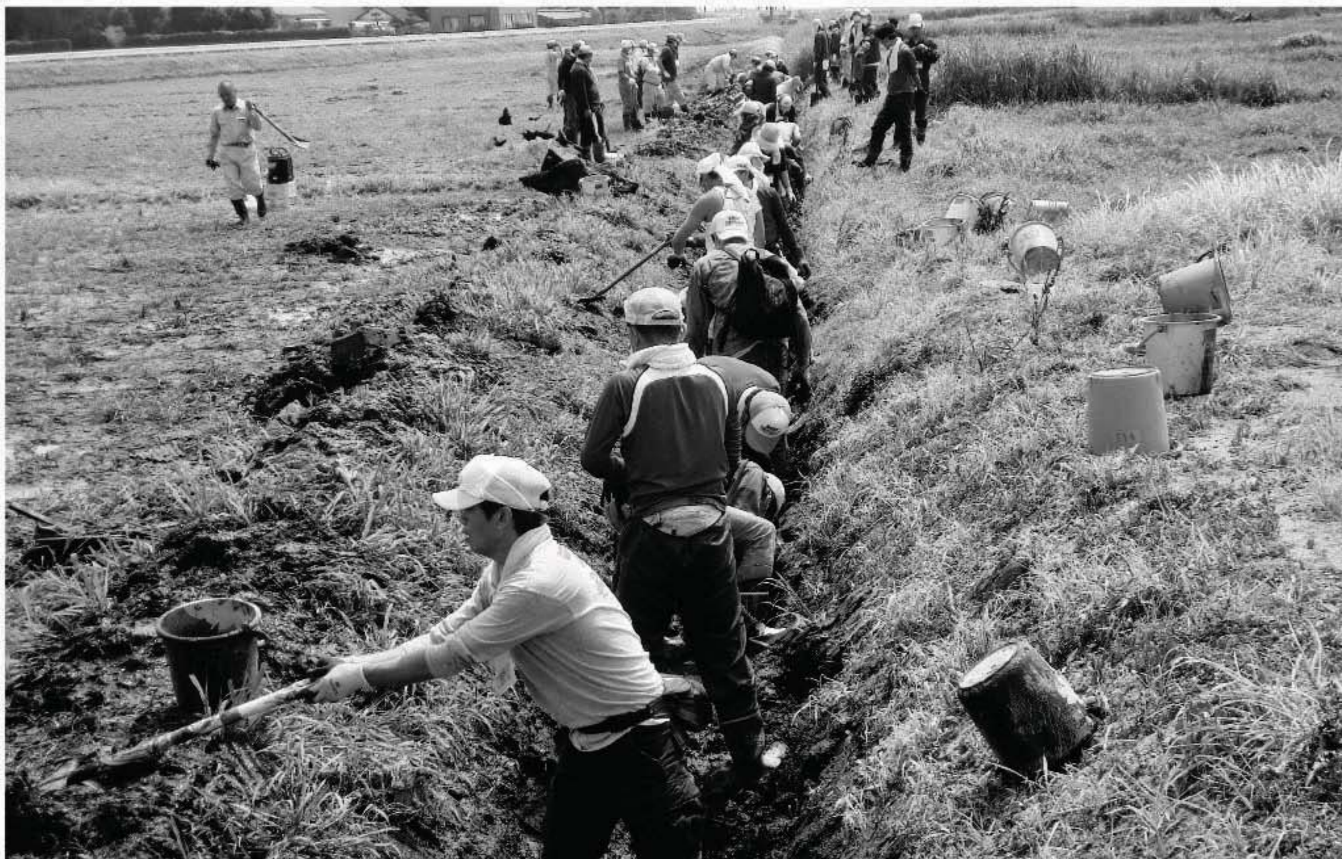
▲側溝の泥出し作業(鹿島区)
