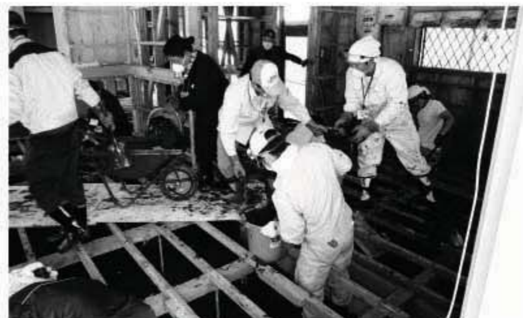
▲床下の泥出し作業
