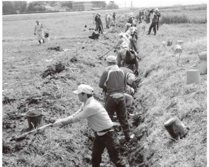
▲側溝の泥出し作業(鹿島区)
